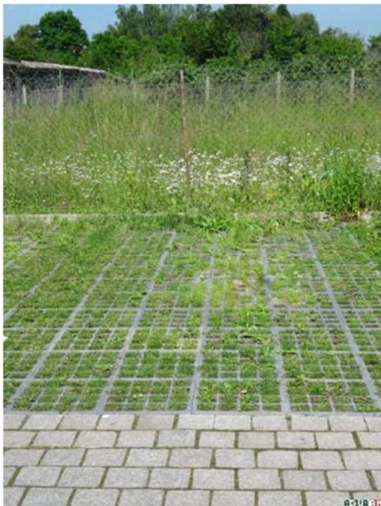
*Parking automobile à revêtement perméable, permettant l'infiltration des eaux de pluie sur le site (rue du Saint-Quentin)*
