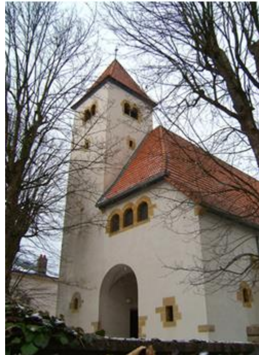
Temple de Longeville-lès-Metz 156b, rue Général de Gaulle
