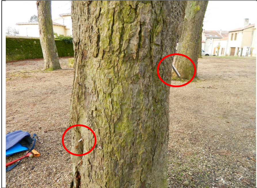
Cavité traversante sur le n°15, sont entourées les extrémités du pic de sondage
