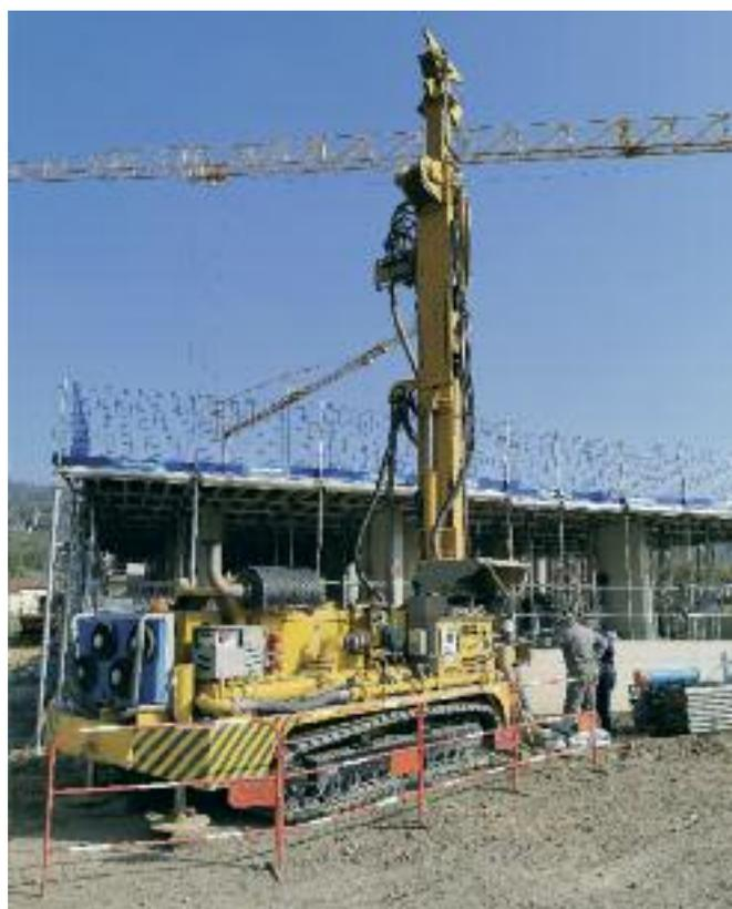
Des forages pour capter la nappe qui sera exploitée pour le chauffage par géothermie.
