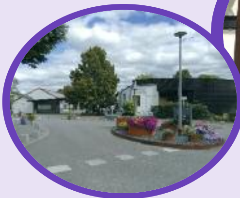
8 Ravalement de façades des écoles et de l'Espace Liberté
