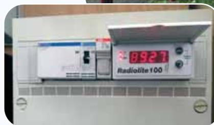
Horloge « astronomique » installée dans les 23 armoires d'éclairage public
