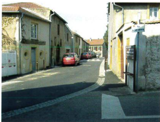
Rues St-Nicolas et St-Vincent : l'enfouissement des réseaux est achevé
