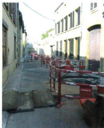
Travaux en cours rue de l'Esplanade
