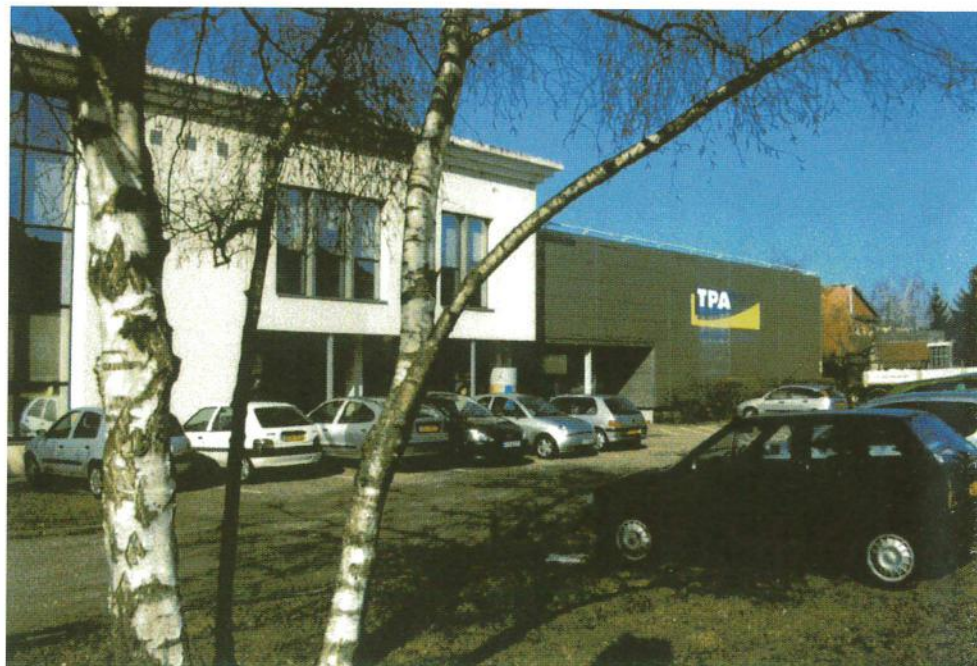
Les locaux à Scy-Chazelles
