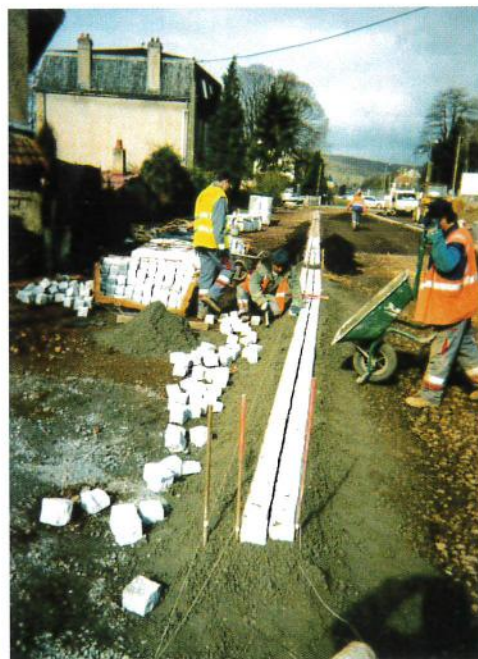
Réalisation du caniveau central
