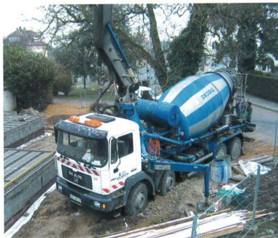
Travaux de couverture de la nouvelle cantine scolaire
