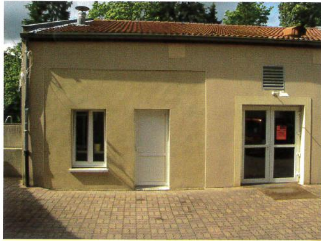
La nouvelle entrée de la cuisine de la salle de l'Esplanade
