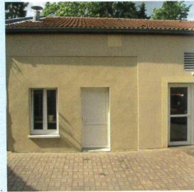
Accès cuisine de l'Espace Liberté
