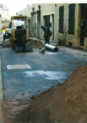
Enfouissement des réseaux
