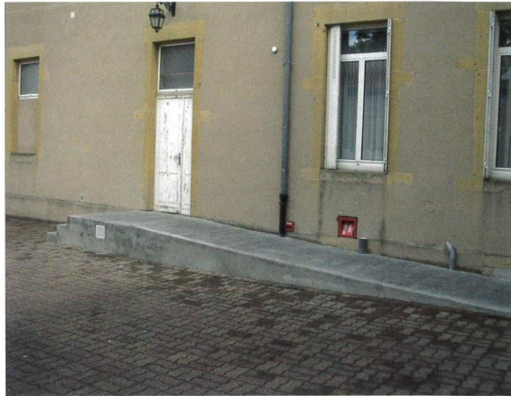
Rampe d'accès de la Mairie
