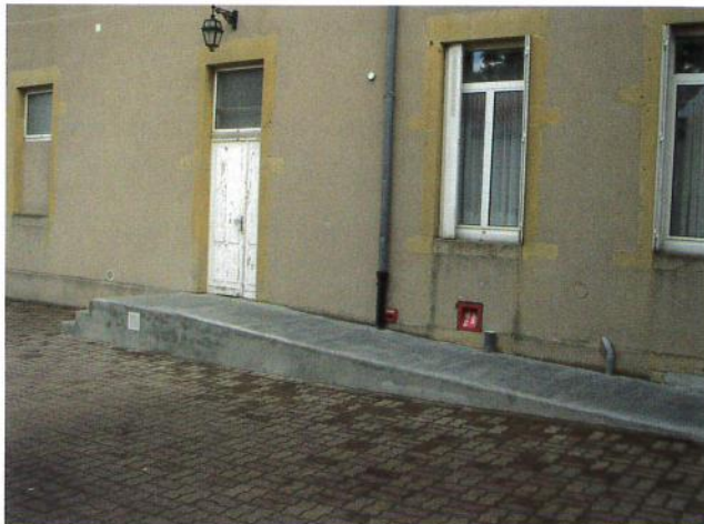
Rampe d'accès à la cuisine de la salle de l'Esplanade
