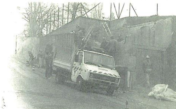
Travaux "Le Corbillard"
